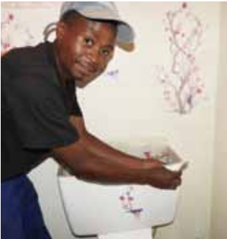
Thabiso Morokwane besig om ‘n toilet te herstel.
